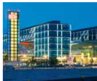
Gare Principale, Berlin Architecte: gmp von Gerkan, Marg and Partners, Hambourg Entreprise de bâtiment: Eichelberger GmbH & Co. KG – Airteam Lufttechnische Anlagen GmbH
