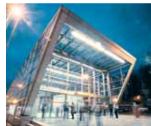
Station de Métro Sarrika, Espagne Architecte: Sir Norman Foster, Foster + Partners, Londres Bureau d'études spécialisé: IMEBISA Entreprise de bâtiment: Etxea Instalaciones
