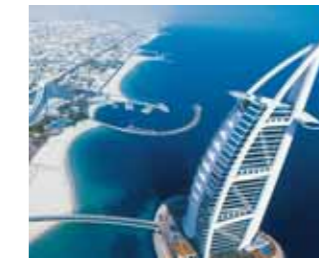
Burj al Arab, Dubai Architecte: Tom Wright, Akins Middle East – W.S. Atkins & Partners, Epsom, Royaume Uni Bureau d'études spécialisé: W.S. Atkins & Partners Entreprise de bâtiment: B.K. Gulf
