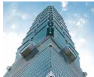
Centre des Finances Tai Pai, Taipei Architecte: Chang Yong Lee & Partners, Taipei Bureau d'études spécialisé: Continental Consulting Engineers Entreprise de bâtiment: Shynrio
