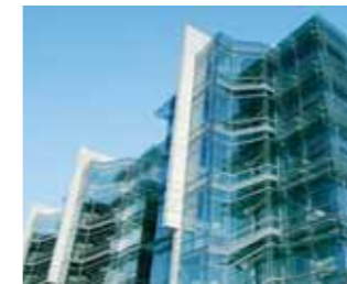
Chambre de commerce, Luxembourg Architecte: Claude Vasconi & Partners, Paris Bureau d'études spécialisé: RMC Consulting Entreprise de bâtiment: ELCO S.A. – ABB Luxembourg – Climlux S.A
