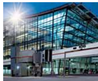
Aéroport de Londres Heathrow, Terminal 5 Architecte: Richard Rogers, Rogers Stirk Harbour + Partners, Londres Bureau d'études spécialisé: WSP Consulting Engineers Entreprise de bâtiment: Amec Building & Facility Services – MACE
