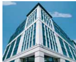
Business center Glacis, Luxembourg Architecte: Jean Petit, Luxembourg – Atelier d'Art Urbain, Bruxelles Bureau d'études spécialisé: Masterplan Entreprise de bâtiment: A+P Kieffer Omnitec Sarl
