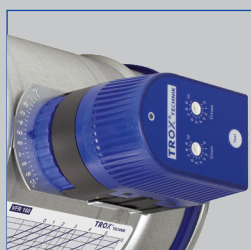
Servomoteur avec potentiomètres
