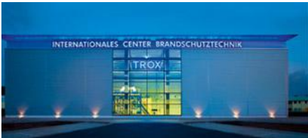
Entre international de protection incendie Protection incendie
