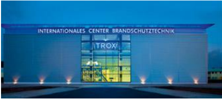
Entre international de protection incendie protection incendie
