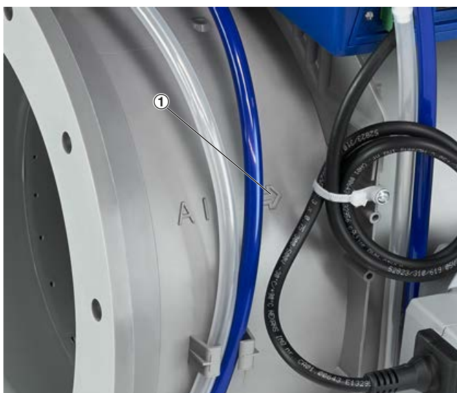
Fig. 9 : Flèche de direction de l'air sur le TVLX
