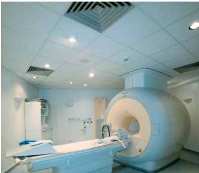
Hôpital Municipal, Düsseldorf, Allemagne
